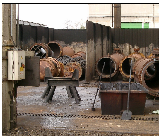
Abb. 6.5: Demontierte Wärmetauscher mit Rohrbündeln (links) und Mänteln (rechts)
